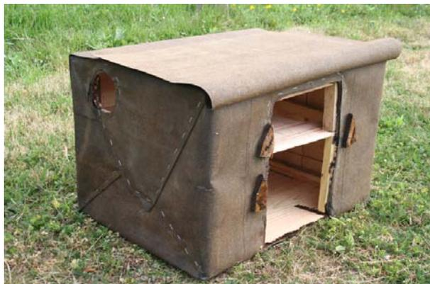
Un revêtement imperméable, est rajouté (matériau de dessous de toiture, en goudron-bitumé)
