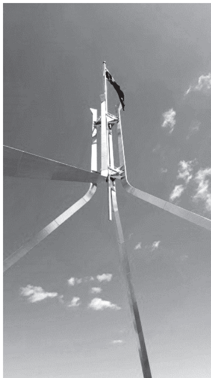
4. kép: A tető felett hatalmas acélrúdon leng az ausztrál zászló (mérete nagyjából egy kétszintes busz méretének felel meg). A rúd 81 méter magas, a szerkezet súlya 220 tonna.*
