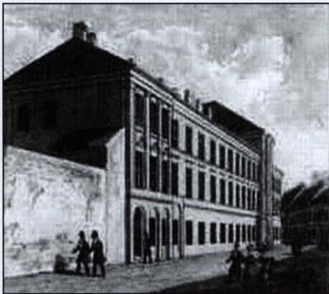
A Helytartótanács budai épülete (metzset)
