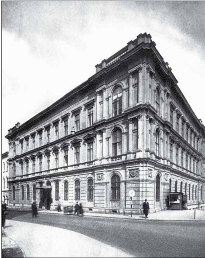
A Legfelsőbb Bíróság épülete 1956-ban (l., Fő utca 1.)
