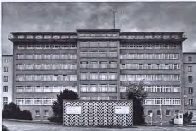
A STASI-börtönmúzeum épülete
