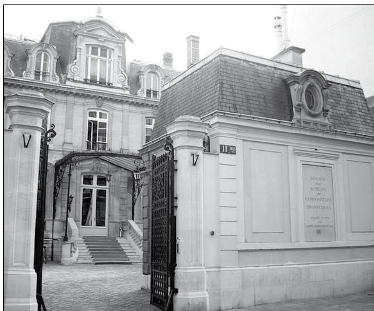
A Société des auteurs et compositeurs dramatiques épülete Párizsban
