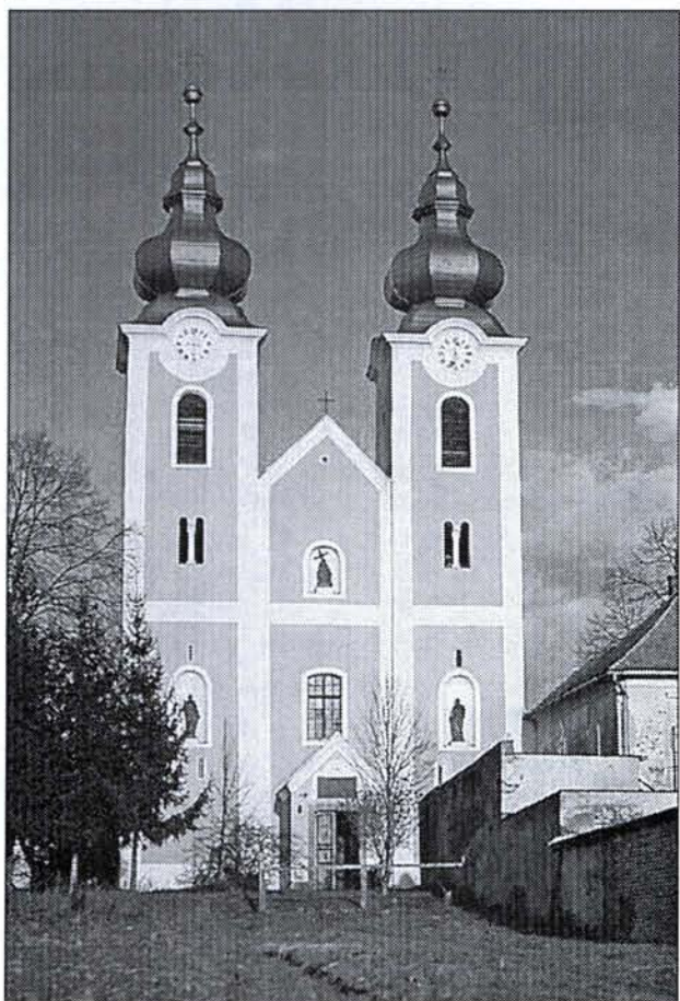
A kapornaki apátsági templom Ny-i homlokzata
